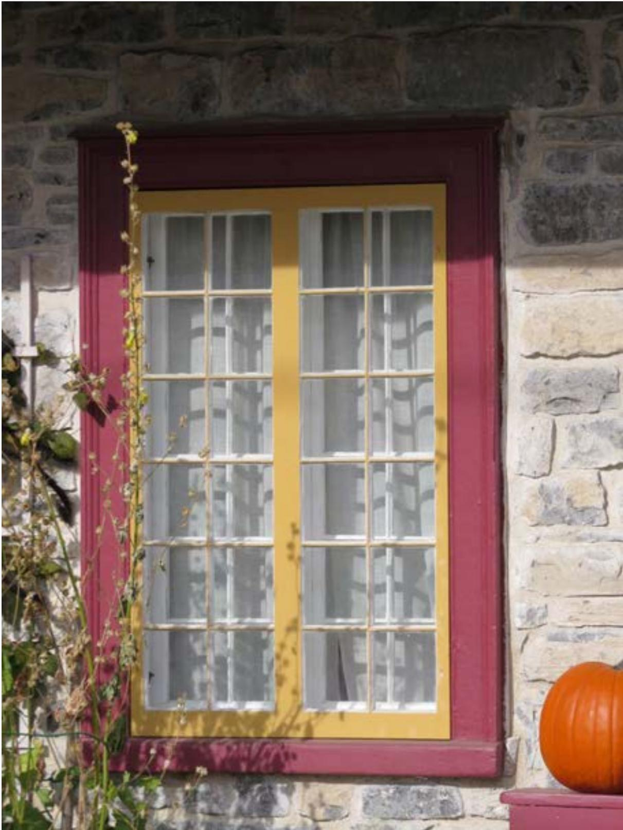
Contre-fenêtre et battants intérieurs à 24 petits carreaux, un modèle très fréquent de fenêtre sur les édifices antérieurs à 1830 sur la Côte-de-Beaupré. 7753, avenue Royale, Château-Richer. IMG\_6167.jpg
